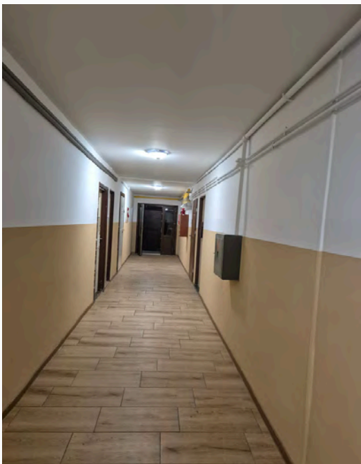
ul. Chodzieska 1 - korytarz po remoncie
