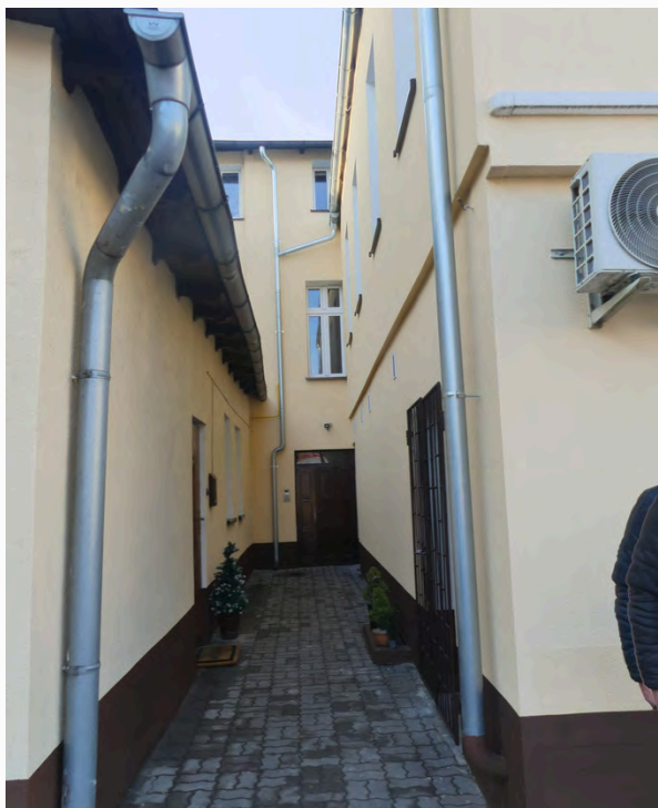
Pl. Wolności 15 i 16 po termomodernizacji
