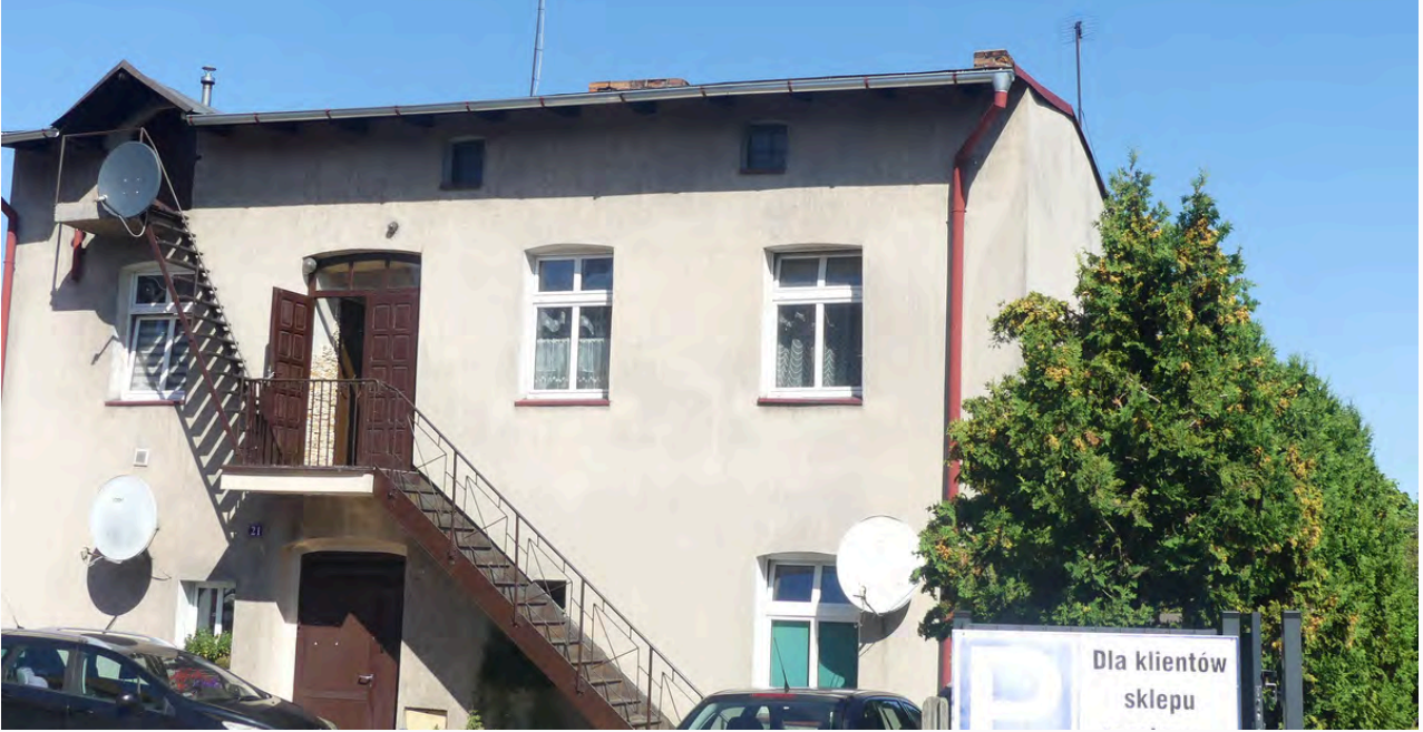
ul. Rybaki 21 – remont dachu
