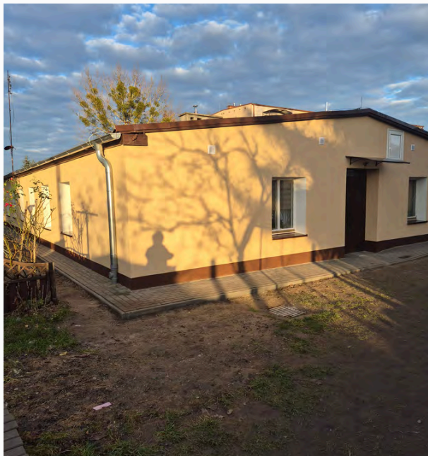
ul. Chodzieska - po termomodernizacji
