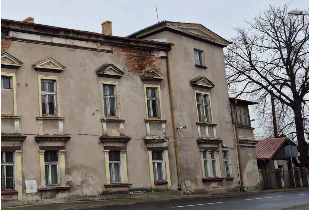
ul. Browarna 1- remont dachu
